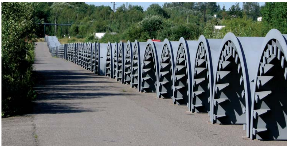
Potrubí pro elektrárnu Belchatow
