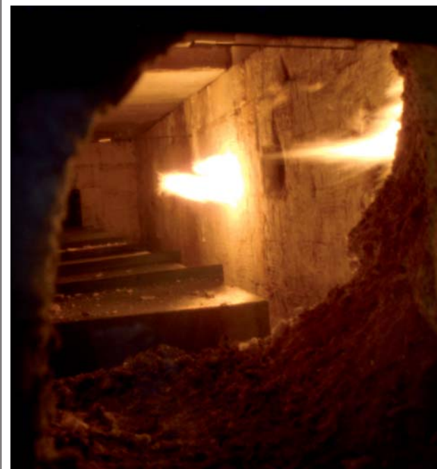
Pohled do pece ze které byl odebrán horký vzduch do zkušební trasy.
