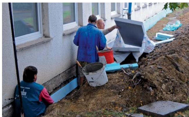
Součástí opravy zdravotního střediska je i zateplení celé budovy.
