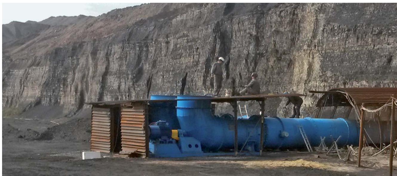
Ventilátory ve velkolomu ČSA odvětrávají na 1700 metrů chodeb bez jakýchkoliv problémů.
