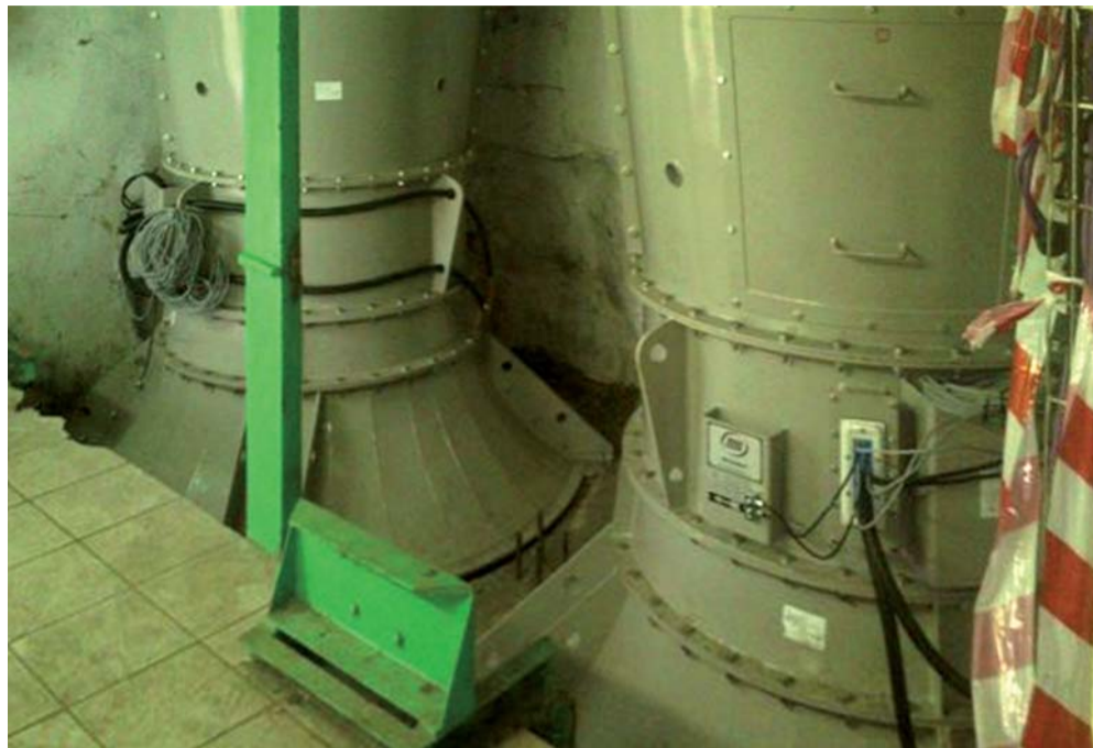
Montáž ventilátorů na stavbě v ukrajinské sladovně Slavuta.
