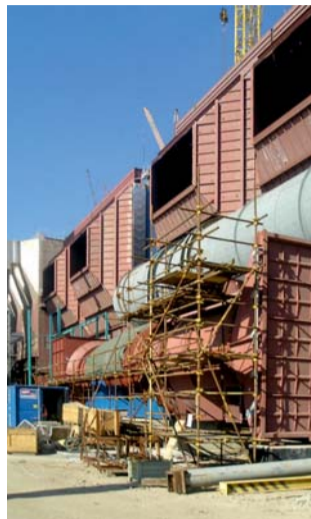
Prunéřov: elektroodlučovače pro bloky 23 a 24
