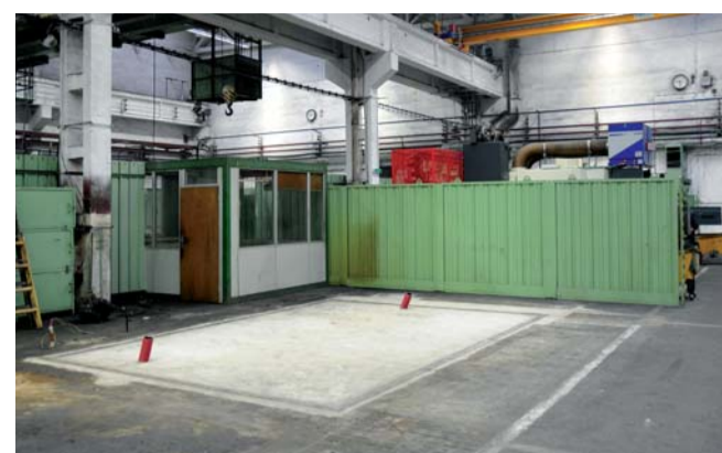
V prosinci začne jeho instalace na připraveném místě.
