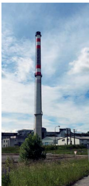
Teplárenský komín s novým nátěrem.
