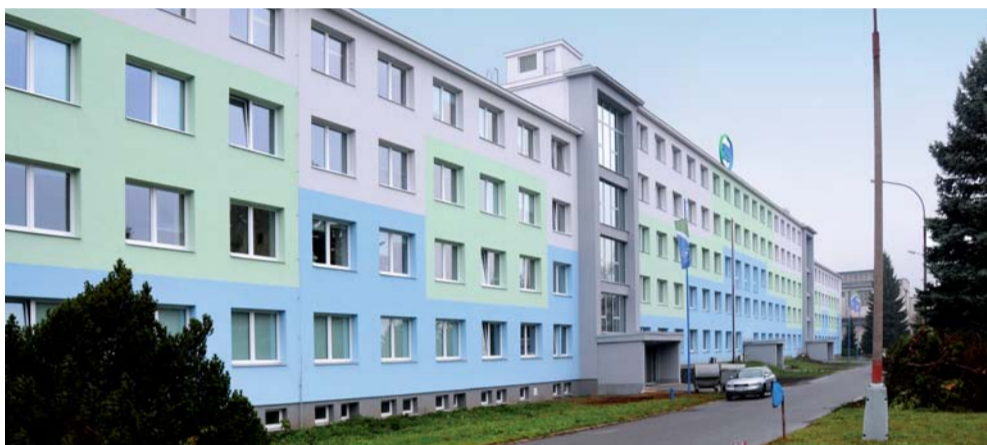
Budovy po dokončení. Jsou zateplené, s novými okny i fasádou.
