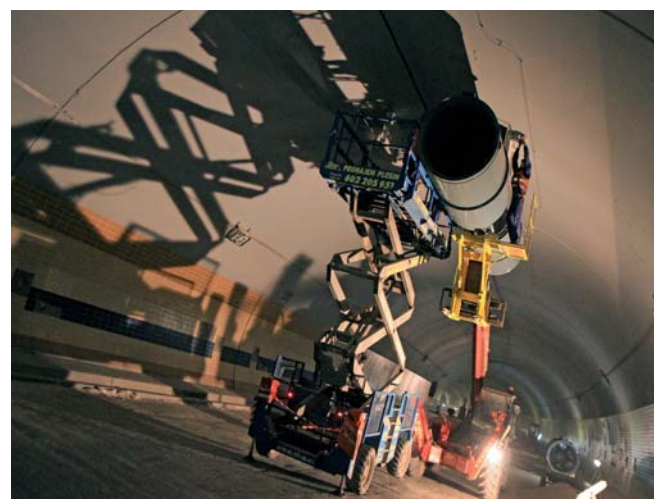
Montáž proudových ventilátorů APWR, kterých je namontováno v obou tunelových troubach celkem 88 kusů
