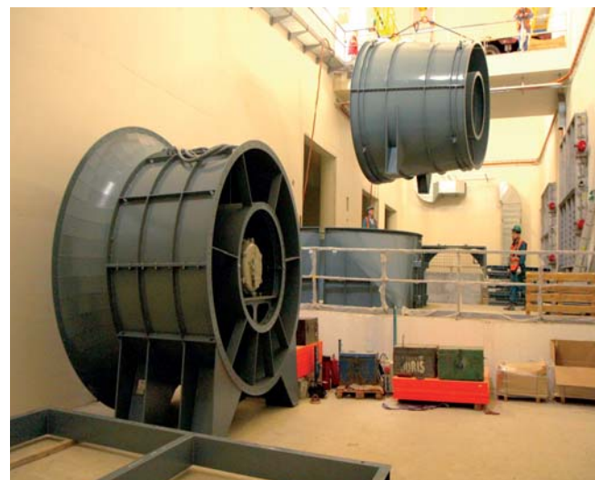
Ventilátor APH 2800 míří do strojovny hlavního větrání Trója
