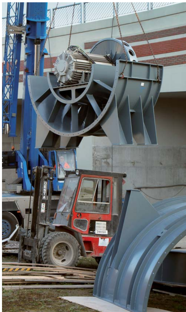
Zavážení ventilátoru APH 3150 do strojovny hlavního větrání Malovanka. Vidět jsou i portály tunelu Blanka navazující na výjezd ze Strahovského tunelu
