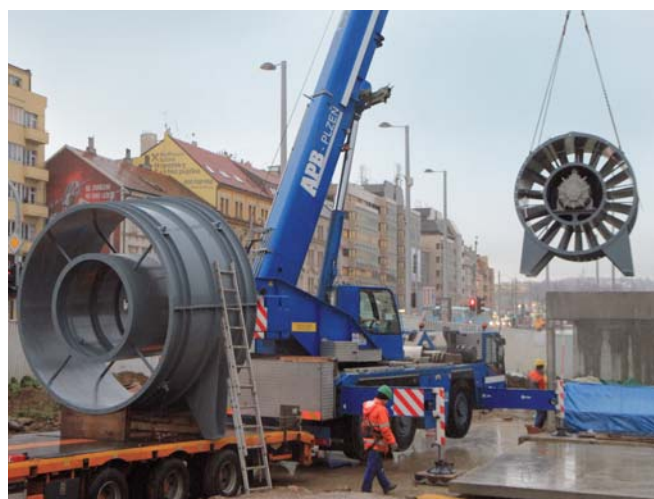
Jeřáb spouští ventilátor APH 2800 do větracího objektu Špejchar. Ten má sloužit pouze jako odsávání tunelu v případě požáru
