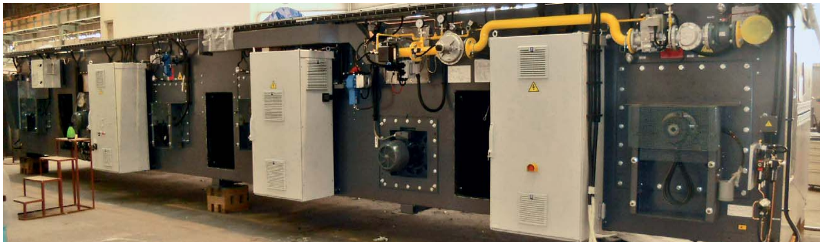
Zadní stěna sušárny
