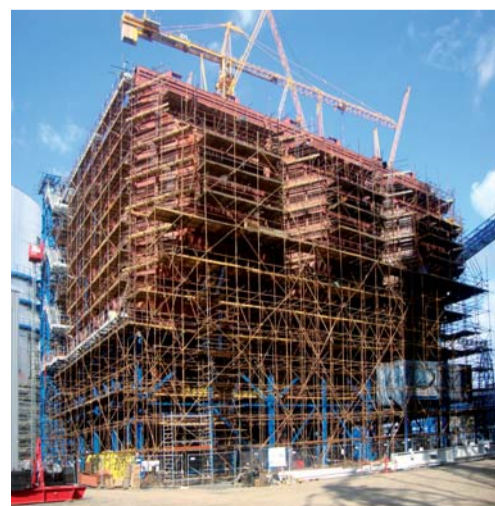
Montáž levého EO
