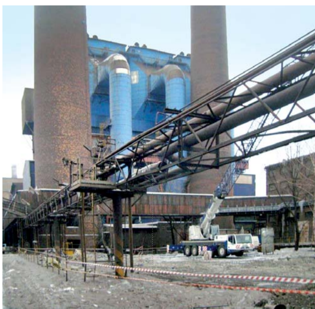
Staveniště před zahájením prací
