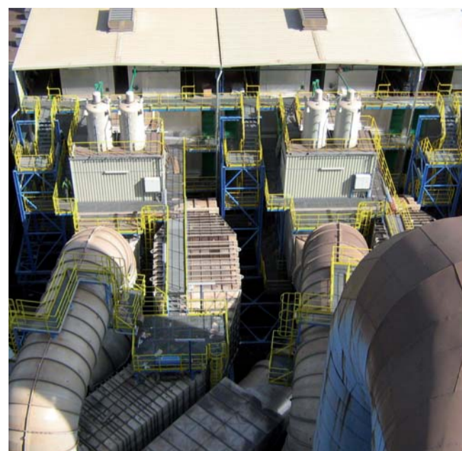
Dokončení montáže druhého stupně odlučování
