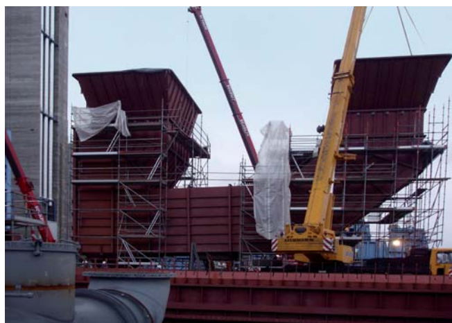
Svařenec rozvodu studeného vzduchu do výměníku vzduchu
